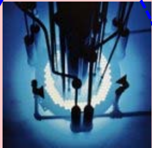
原子炉安全性研究炉 (NSRR)
